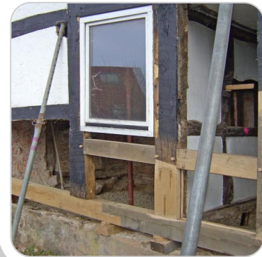
Austausch Gefache bei Fachwerkhäusern
