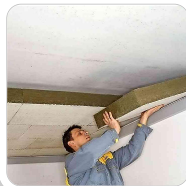
Dämmung der Hauseingangsdecke von unten
