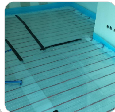
Die Wärmeverteilung wird durch eine effizientere Fußbodenheizung ersetzt
