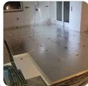
Verlegung einer Fußbodendämmung
