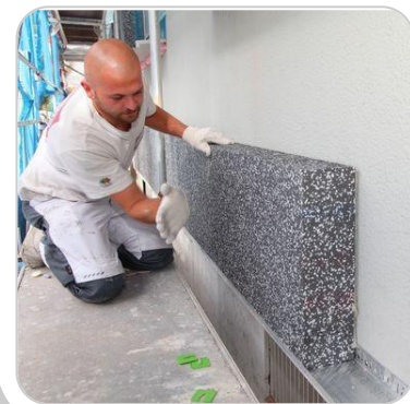
Anbringen eines WDVS
