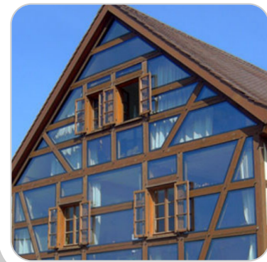
Bei Fachwerkwänden ist besonders auf Feuchteschäden zu achten
