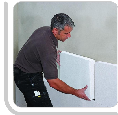
Dämmen einer Wand gegen Unbeheizt
