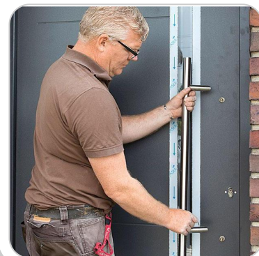
Ein Einbau einer neuen Außentür bietet zudem mehr Sicherheit
