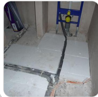
Die Dämmung des Bodens kann mit anderen Arbeiten kombiniert werden
