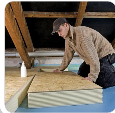
Dämmung der obersten Geschossdecke
